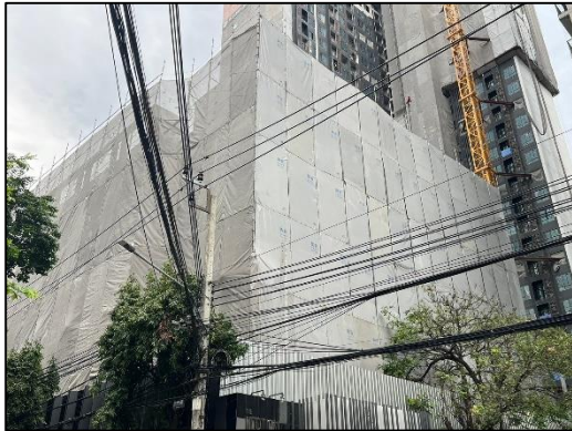
ภาพที่ 22 Sound Barrier ป้องกันเสียง
