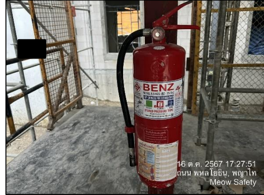
ภาพที่ 42 ถังดับเพลิงและการตรวจสอบ พร้อมป้ายแนะนำการใช้
