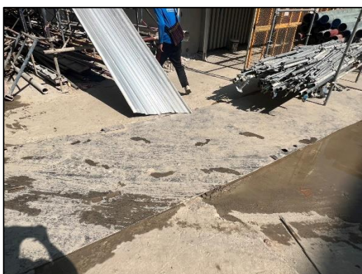
ภาพที่ 20 แผ่นเหล็กปูบริเวณรวิ้งผ่าน
