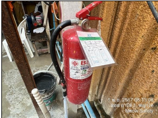
ภาพที่ 42 ถังดับเพลิงและการตรวจสอบ พร้อมป้ายแนะนำการใช้
